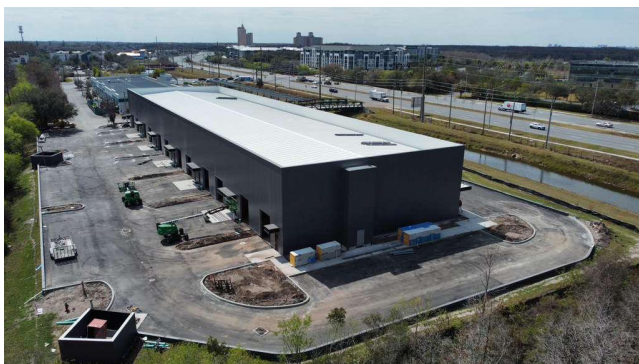
Estructura terminada, vista aérea – frente sobre John Young Parkway
