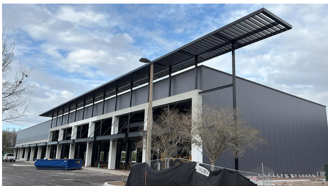
Marquesina de acero en voladizo de la fachada y acceso vidriado
