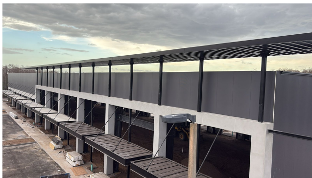
Acero de la marquesina a lo largo de la línea de fachada, en construcción
