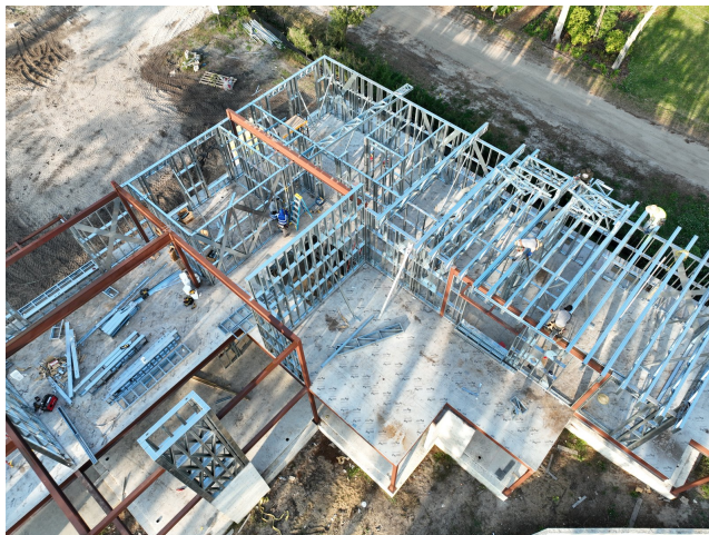
Vigas de acero pesado que soportan los muros y el entrepiso de acero liviano
