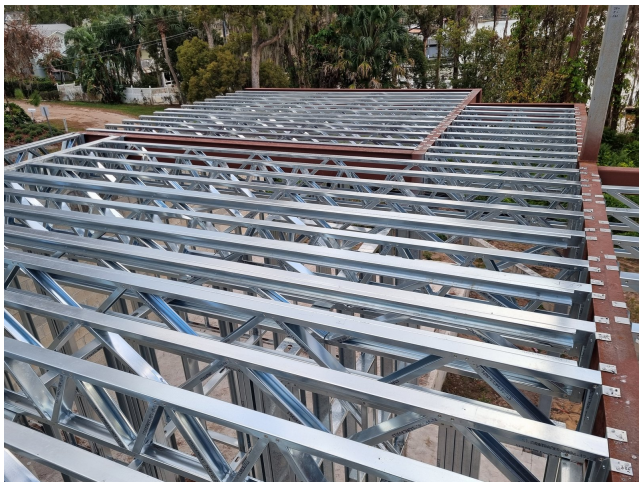
Cerchas de entrepiso de alma abierta AT Steel LGS sobre una viga de acero pesado
