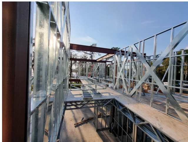
Muros estructurales de acero liviano y acero pesado enmarcando la vista al lago
