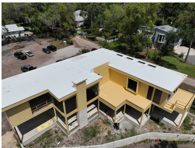
Estructura cerrada – estuco y cubierta por otros sobre la estructura de AT Steel
