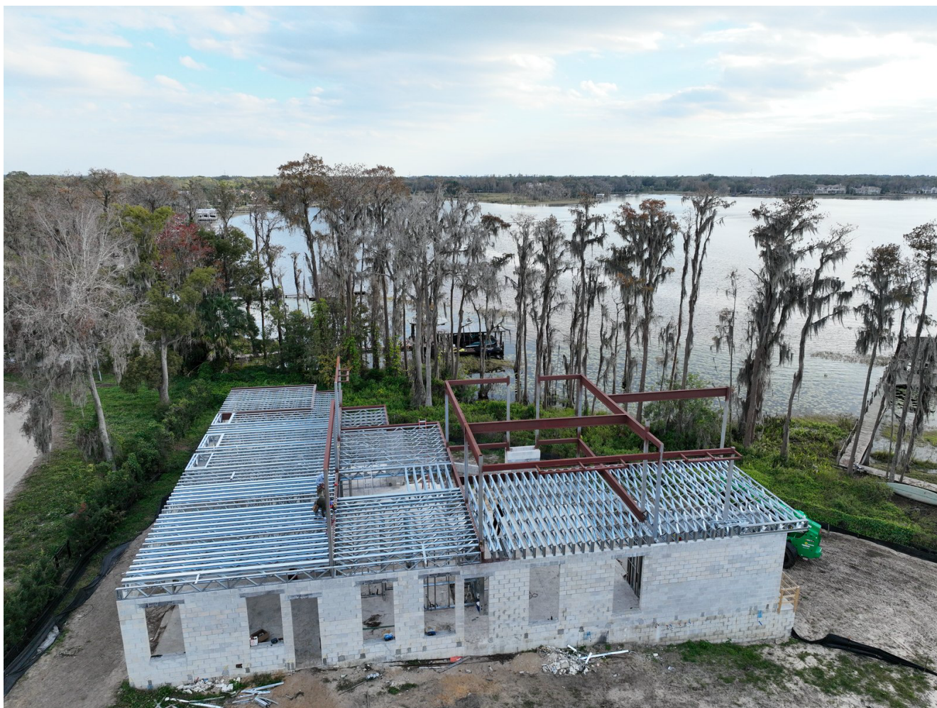
Paquete de estructura de AT Steel montado en sitio – residencia frente al lago, Windermere, FL
