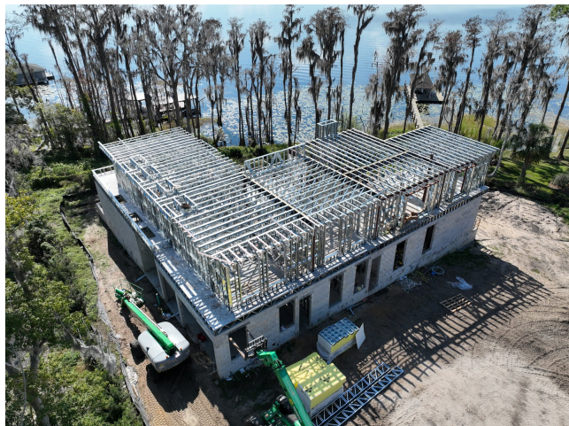
Plataforma completa de cerchas de entrepiso LGS que forma el segundo nivel
