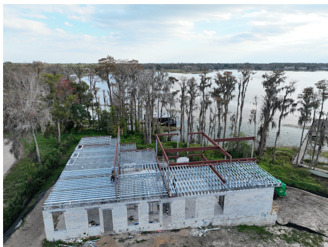
Estructura frente al lago, vista aérea – cerchas de entrepiso LGS y acero pesado
