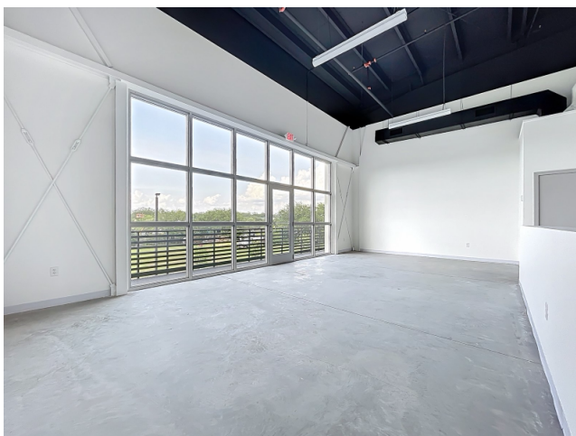
Acero estructural expuesto, arriostramiento con barras en X, acristalamiento de frente comercial
