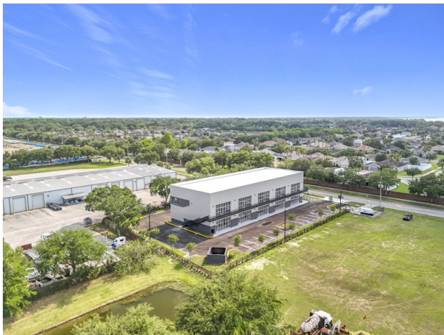
Marco rígido primario durante el montaje
