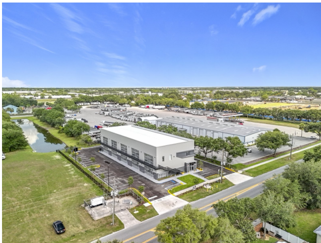
Estructura de dos niveles completada, vista aerea
