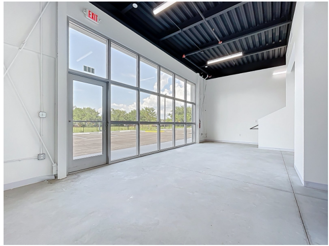
Paneles de envoltente en instalacion
