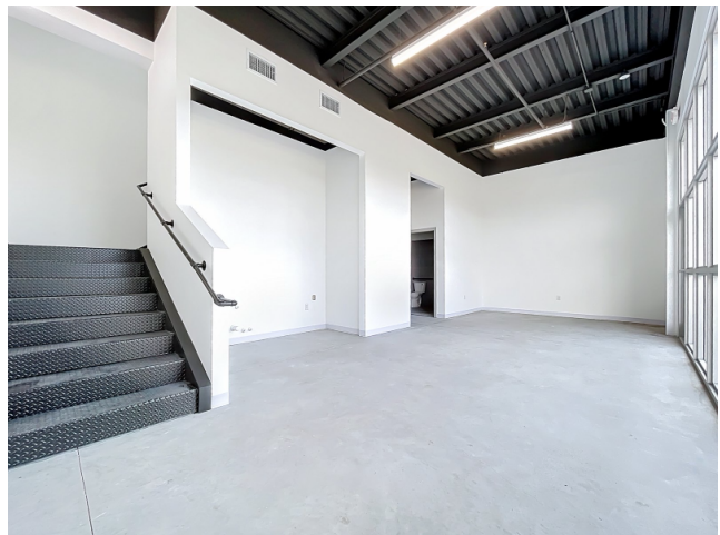
Arriostramiento y estructura de entrepiso, durante la construcción
